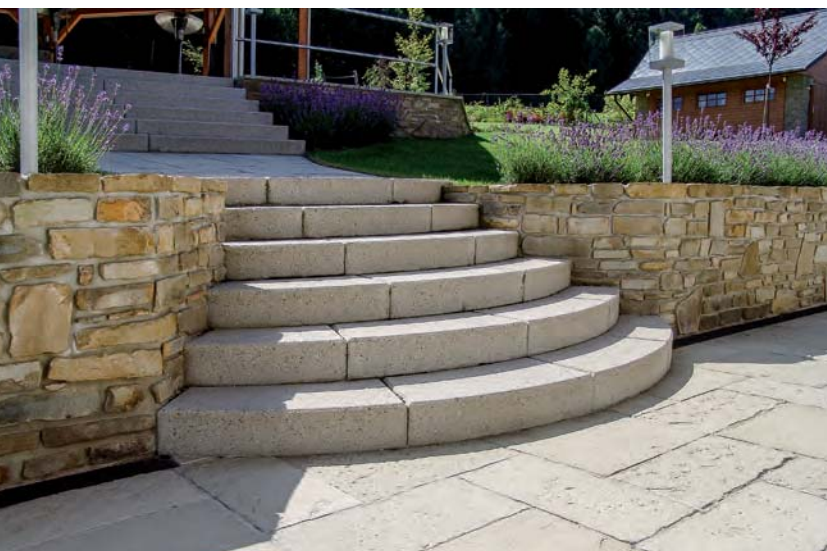
Schodišťové stupně obloukové
