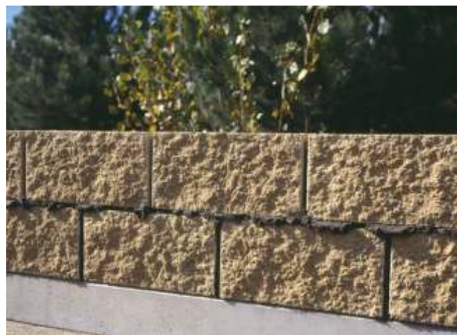
obr. 4 Vytlačenou maltu odstraníme až po mírném zavadnutí, zabrání se tak možnému znečištění tvárnic.
