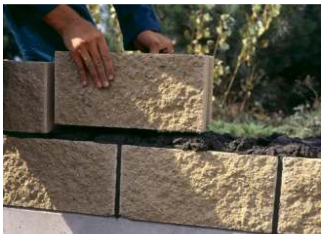
obr. 3 Malta vytlačená ze spár neodpadává a po seřízení se dá znovu použít.
