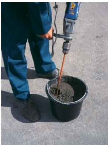
obr. 1 Suchou maltu lze rozmíchat s vodou v libovolné nádobě nebo v míchačce.
